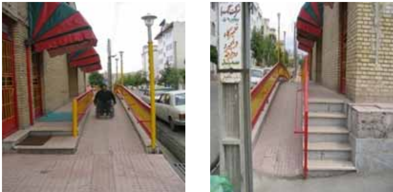
تصاویر شماره ۲۰۸۲ و ۲۰۸۳: نمونه‌هایی از سطوح شیبدار اجرا شده در فضاهای باز شهری، شهرک شاهد، تهران. مأخذ: مؤلف
