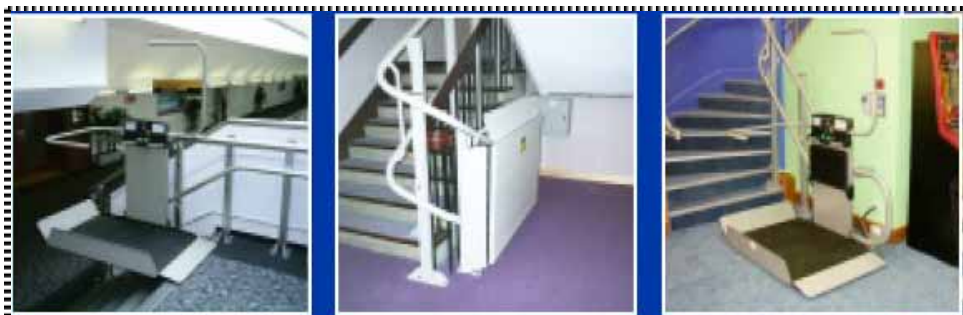
شکل ۴-۱۰ بالابرهایی که ویلچر بر روی آنها قرار می‌گیرد (۹) در شکل ۴-۱۱ و ۴-۱۲ هم نمونه‌ای از شماتیک این بالابر را مشاهده می‌کنید.
